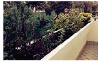
Η μεμβράνη IDROPLAST ANTIRADICE χρησιμοποιείται για αδιαβροχοποίηση σε ζαρντινιέρες από σκυρόδεμα.
